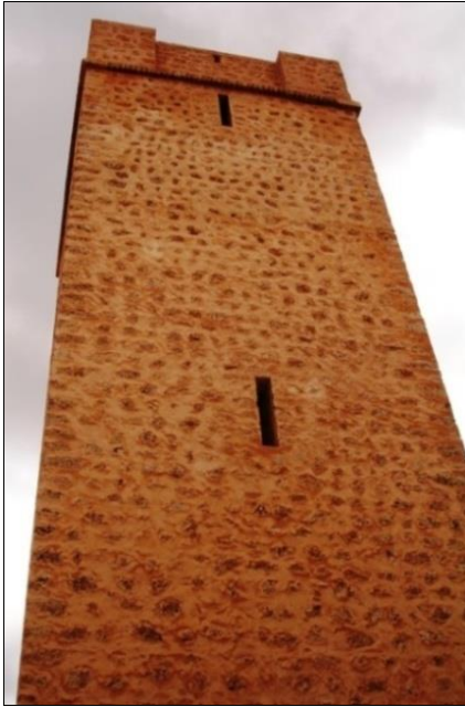
الصومعة بعد الترميم
