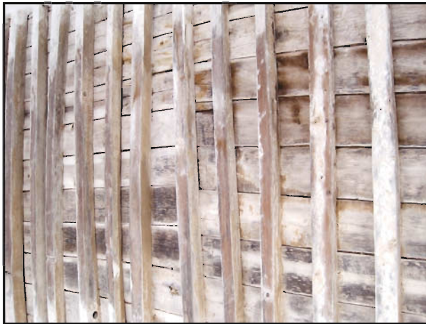
الصورة 6 جانب من سقف الغرفة المخصصة لإيواء الطلبة (أرشيف شخصي)
