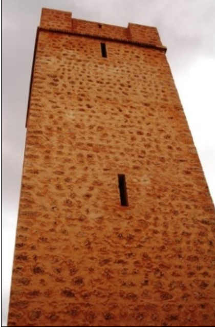
الصومعة بعد الترميم
