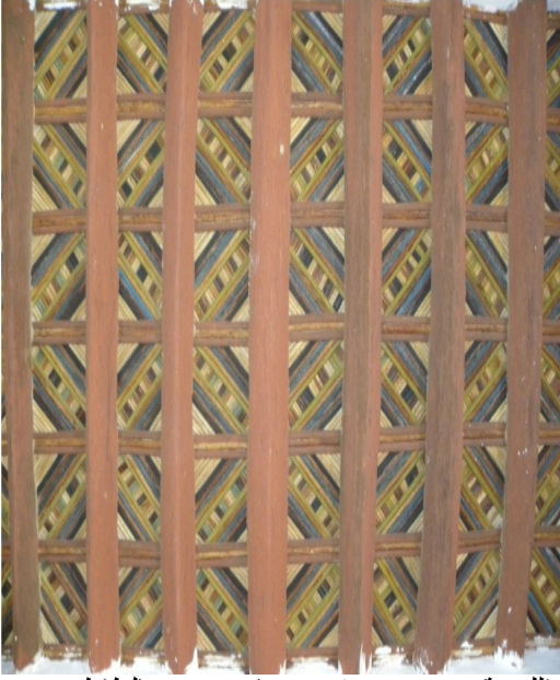
اللوحة 15 : سقف مما يعرف بالطاطوي، رياض أسرة أيت بونعيلات، توك الريح بطاطا، 2011.
